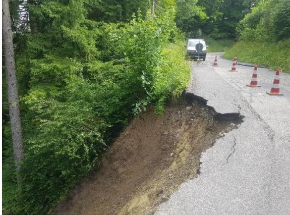
En raison de l'instabilité du terrain et donc de la route au droit de ce nouveau glissement, une fermeture immédiate et complète du tronçon a été décidée en collaboration avec la DGMR et le bureau spécialisé en géotechnique convoqués sur place en urgence.
