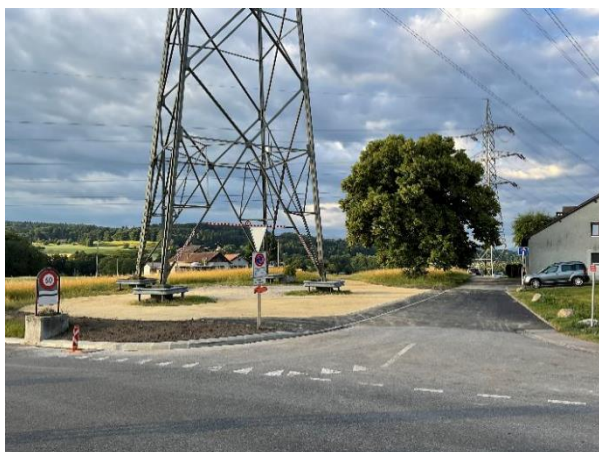
Réaménagement de l'accès au chemin de Maupras
