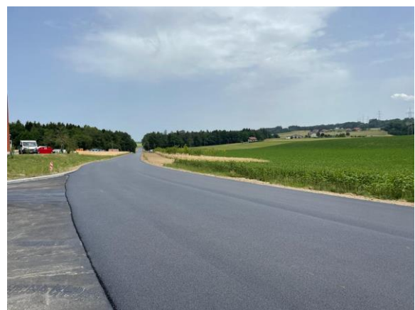
RC 501 – Pose du revêtement final
